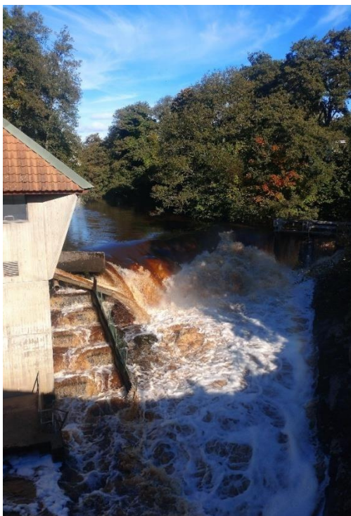
Bobergs Kraftstation 2024-09-29 Foto: Ingvor Johansson
