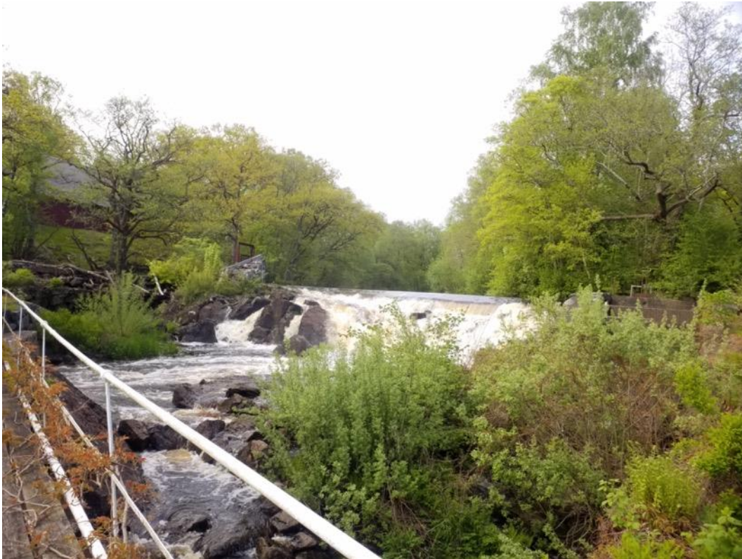
Figur 27. Fallet vid Mostorps kraftverk. Här rinner fåran över en naturlig bergströskel (hydromorfologisk typ A-Sträckor i fast berg. Sträckan är dock kraftigt modifierad i och med anläggandet av dämmande strukturer. Fallet bedöms som ett partiellt vandringshinder i dagsläget för lax och öring men som ett definitivt hinder för svagsimmande fiskarter. En äldre fiskväg i form av en laxtrappa finns vid dämmet.
