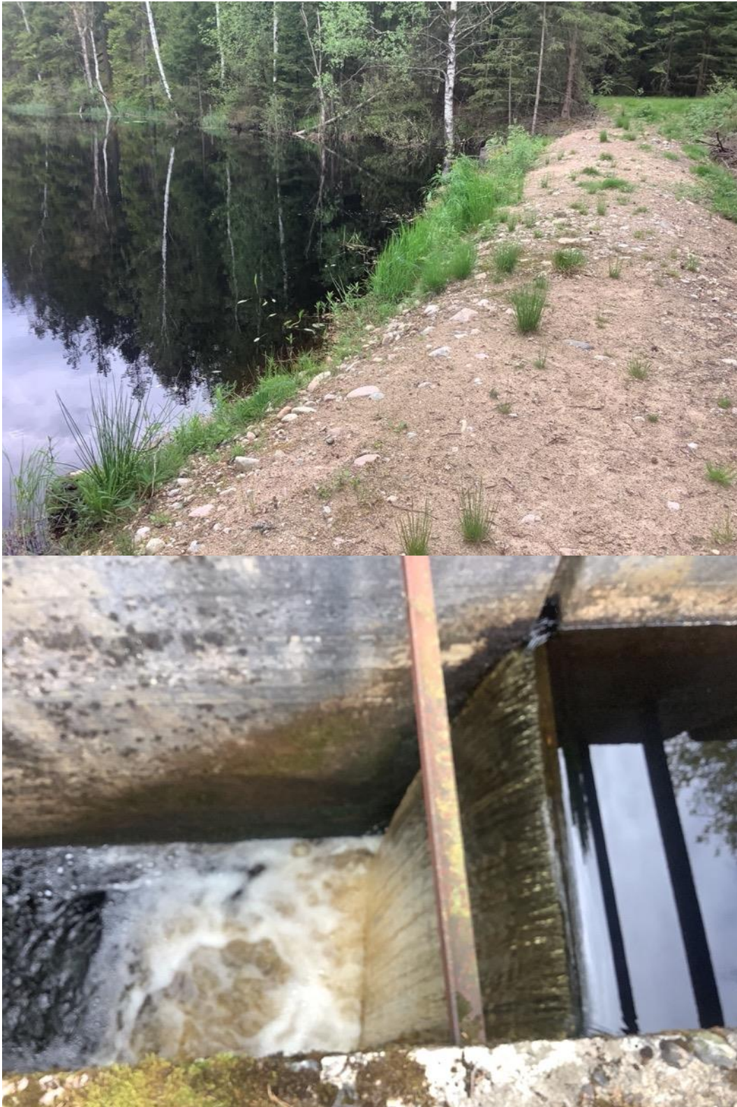
Figur 65. Dammvall (övre bild) och skibord (nedre bild) på den nedre dammen vid Pugabols dammar. Dämnet bedöms vara ett definitivt vandringshinder.
