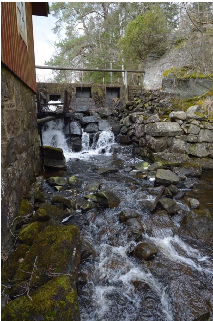
Figur 49. Dämnet vid Knobesholm som bedöms vara ett definitivt vandringshinder för både starksimmande och svagsimmande fiskarter.
