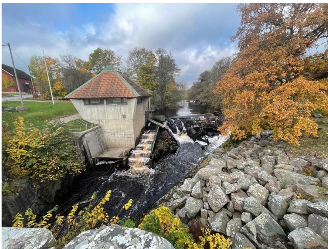
Figur 10. Kraftverket vid Boberg med laxtrappan i anslutning till kraftverksbyggnaden. Fallet bedöms vara ett partiellt vandringshinder för starksimmande fisk såsom lax och öring och ett definitivt vandringshinder för svagsimmande fiskarter.
